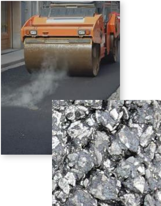
Revêtement de chaussée
