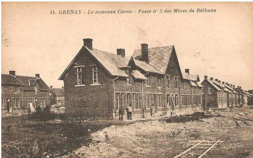
Cité n° 5 de Béthune de la fosse n° 5 - 5 bis de la Compagnie des mines de Béthune dans le bassin minier du Nord-Pas-de-Calais, Grenay et Loos-en-Gohelle, Pas-de-Calais, Nord-Pas-de-Calais, France. 1900-1910.
