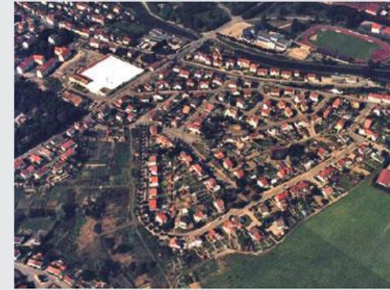
Le quartier de la Marseille, des cités-jardins (mairie de Thaon-les-Vosges, fin des années 1980)
